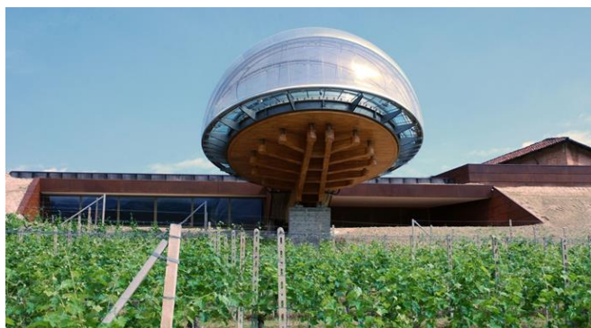
Photo 5 : Domaine viticole de Ceretto à ALBA (Italie). Structure entièrement réalisée en chêne lamellé-collé, avec un porte-à-faux de 6,30 m, surmontée d'une bulle faisant office de salle de dégustation et offrant une vue à 360° - Crédit photo SIMONIN
